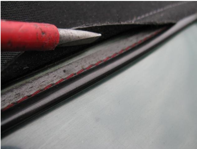
Abb. 37: Kein Dichtband!
